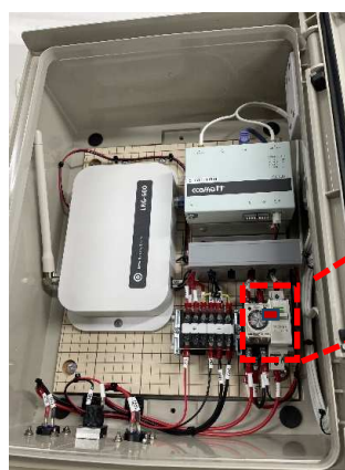
親機本体ボックス内（内部の配置は機種により異なる場合がありますが、電源部の構成は共通です）
